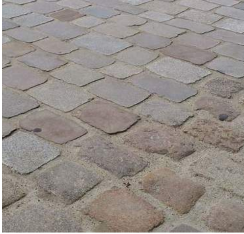
Abbildung 9: Abgeschliffenes Kopfsteinpflaster (Quelle: NeumannConsult)
