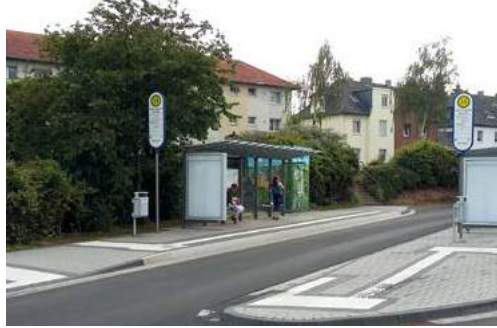
Abbildung 16: Bushaltestelle (Quelle: IBH Ingenieurbüro Hartmann, Bonn)
